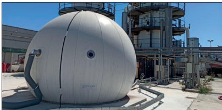
Gasometro per la regolazione del biogas e dei digestori
