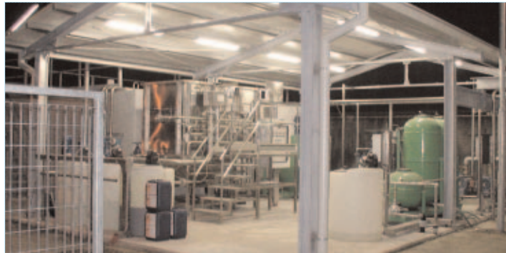
• L'IMPIANTO DEL SISTEMA DI TRATTAMENTO DELLE ACQUE REFLUE CON FLOTTATORE REALIZZATO PER UNA OFFICINA FERROVIARIA
